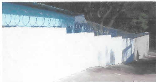
Foto 1: Remozamiento muro perimetral de block
