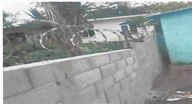
Foto 2: Remozamiento muro perimetral de block
