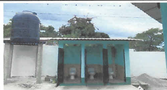
Foto 3: Sustitucion de baños y puertas de baño. Suministro e instalacion de base de metal para colocacion de rotoplas
