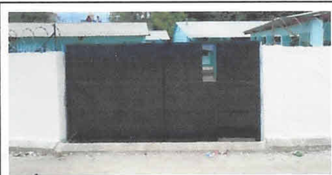
Foto 6: Mantenimiento de porton lijado y soldadura
