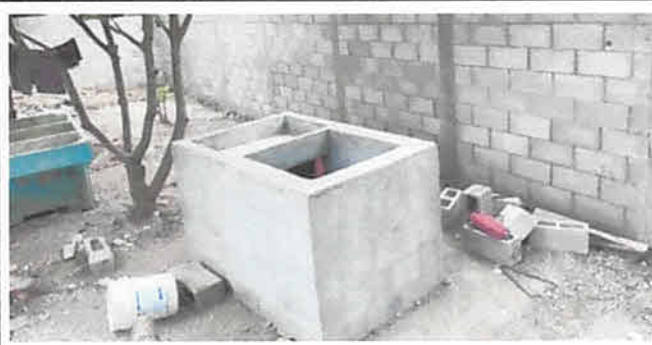
Foto 4: Sustitucion de pila por pila concreto de un lavadero capacidad de 5 toneles aproximadamente
